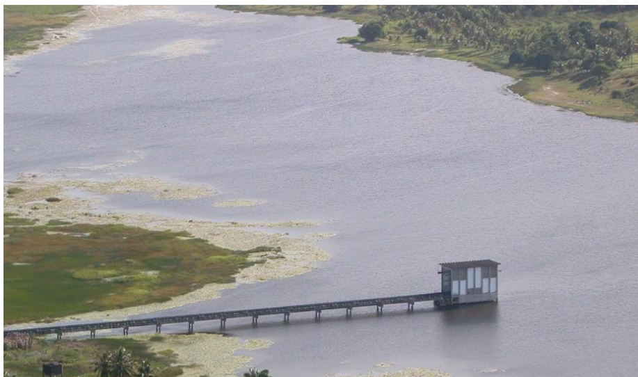
Figura 5 - Lagoa de Extremos Fonte: Administração central da CAERN (2009)
