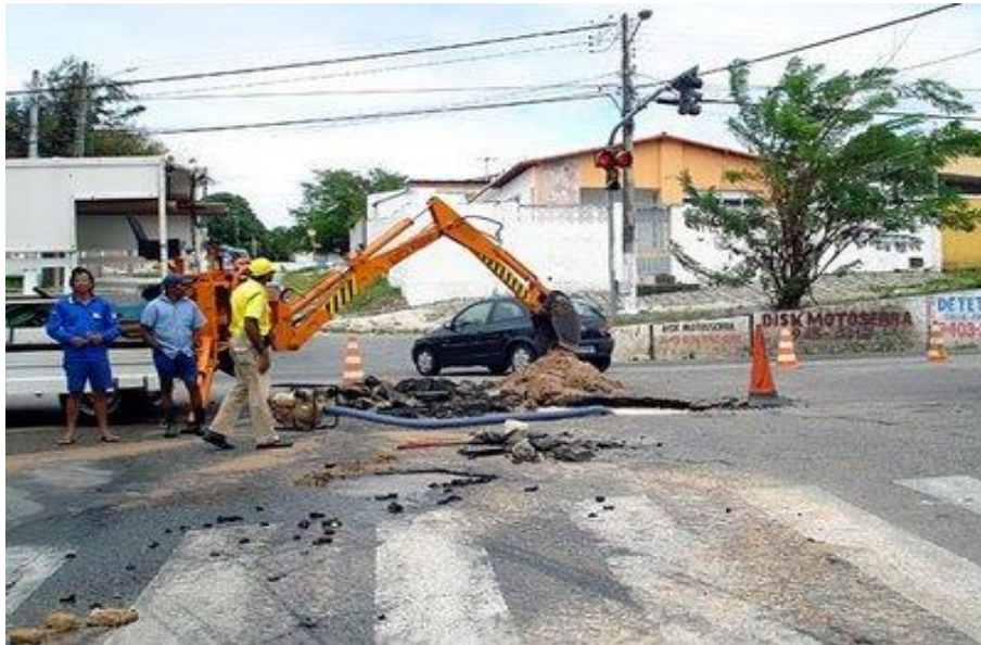
Figura 4 - Restauração de encanamentos com defeito. Fonte: Administração central da CAERN(2009)
