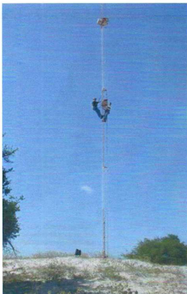
Figura 10 – Montagem de torre medição com 50 metros de altura
